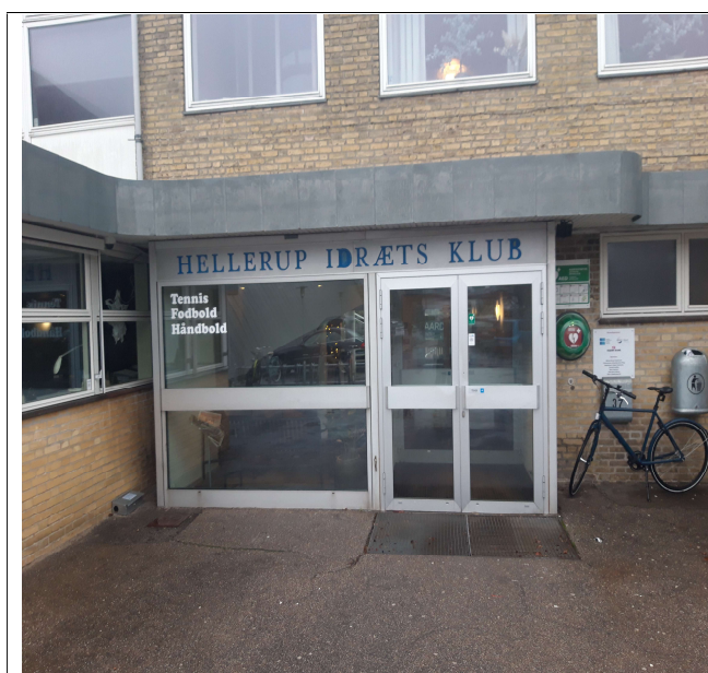
Vindfang i Hellerup Idrætsklub
